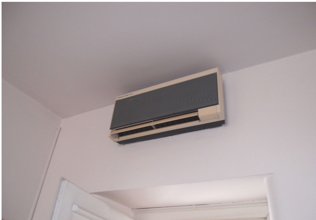
Obr. 3: Klimatizační nástěnná jednotka Hitachi - RAS-2103GWX – m. č. 2324
