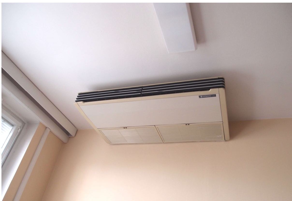
Obr. 22: Klimatizační podstropní jednotka Hitachi – m. č. 2421
