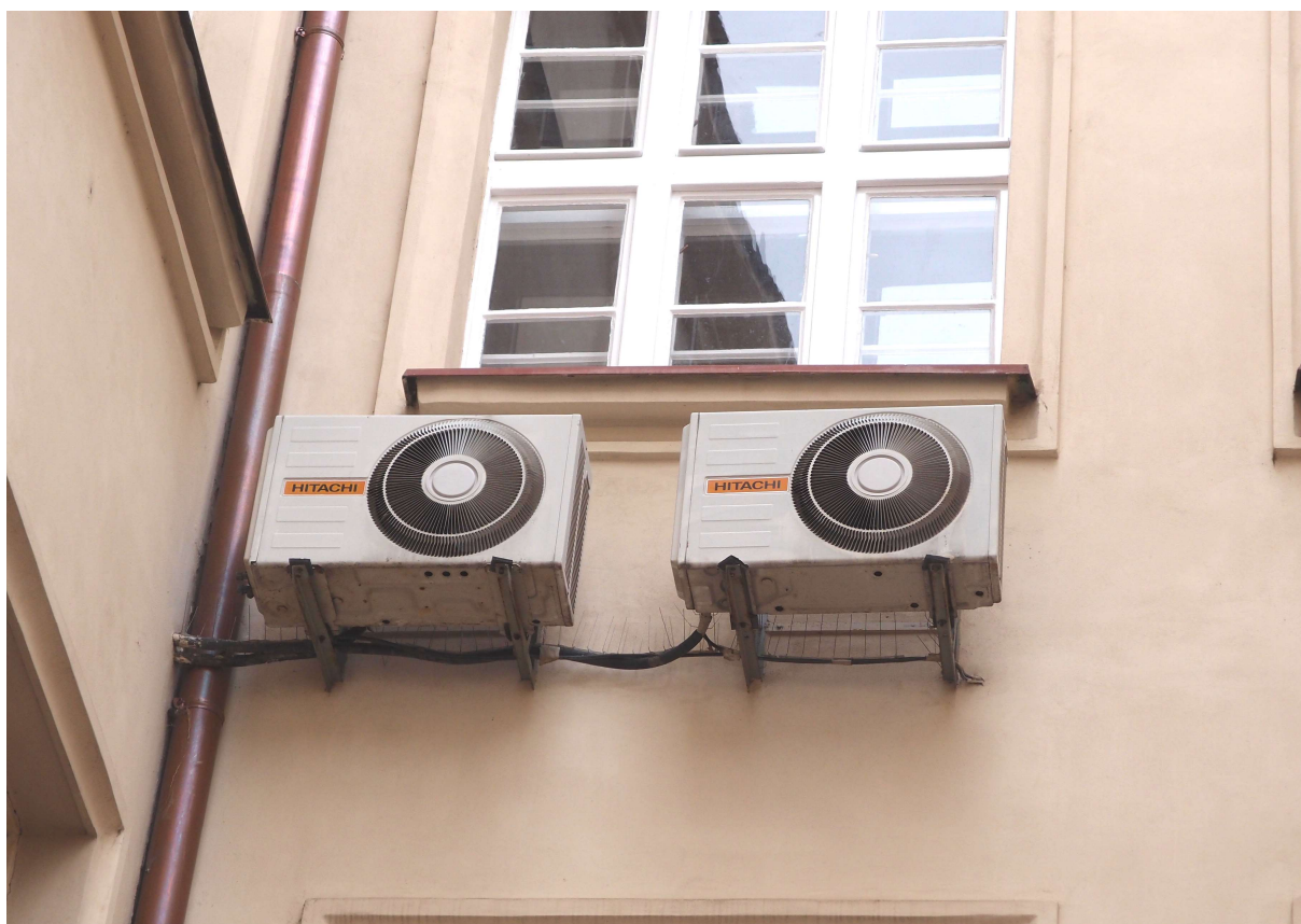
Obr. 20: Venkovní kondenzační jednotka – systém HIC5-1, HIC5-2
