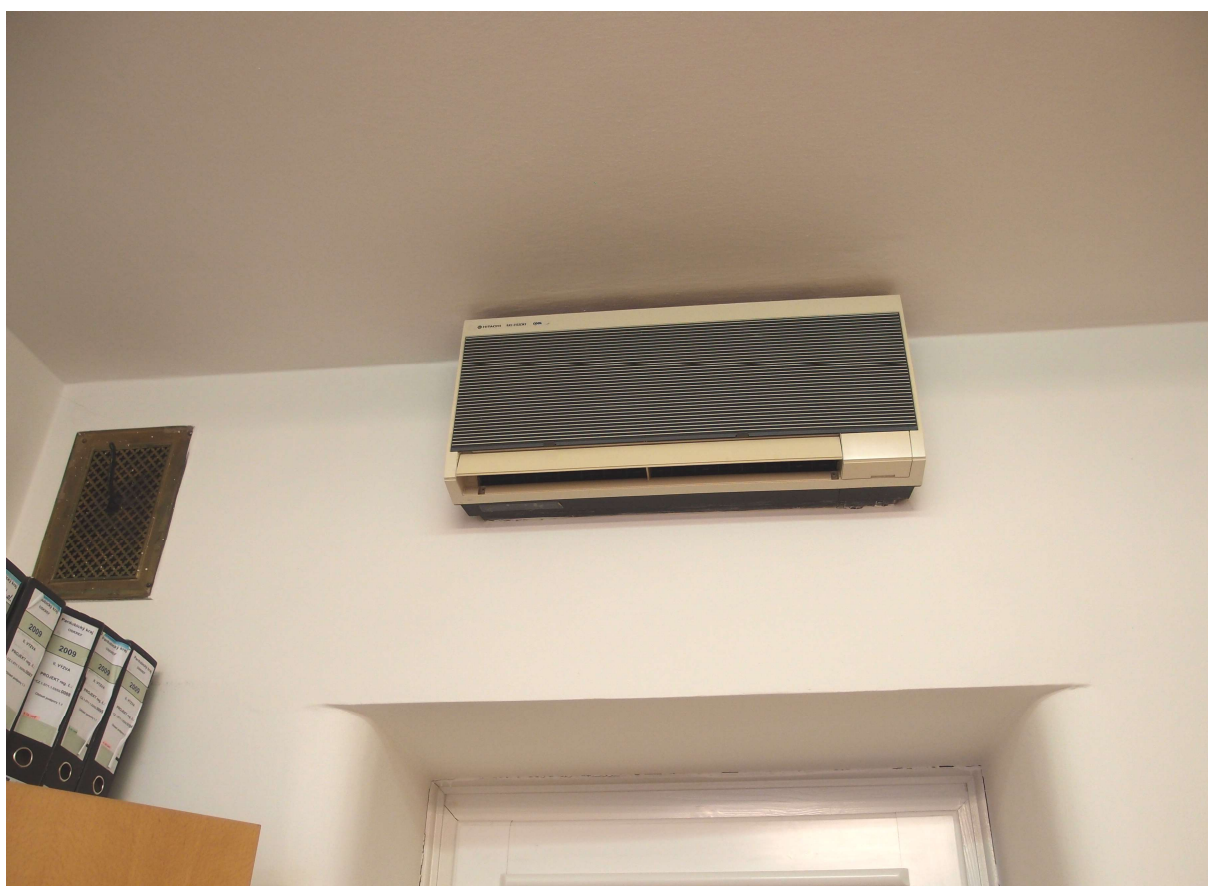
Obr. 6: Klimatizační nástěnná jednotka Hitachi - RAS-2103GWX – m. č. 2327
